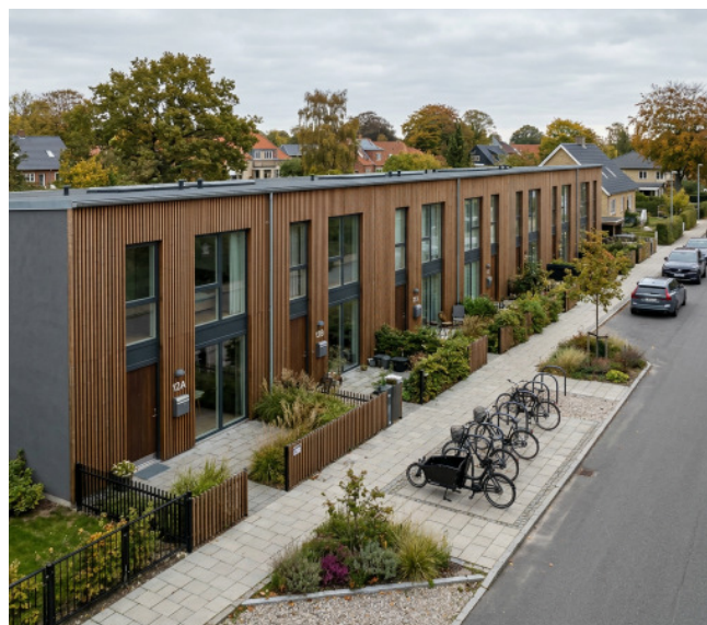
Trælameller på facade.
