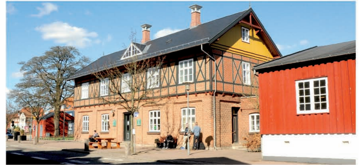
Ry Station – med den ældste del fra 1871 – er stationsbyens eneste fredede bygning
